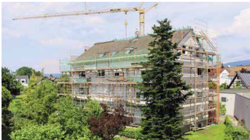
Gut saniert in Gundelfingen
