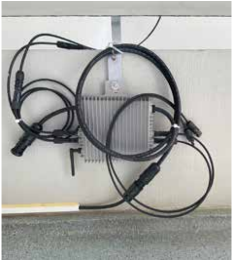
... ein Wechselrichter speist die Energie als Wechselspannung ein.
