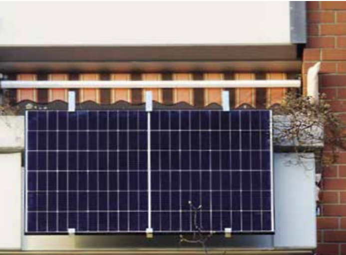
Sonnenkraftwerk: Die am Balkon hängenden Solarmodule (Bild oben links) werden fachgerecht und rückbaubar am Geländer (oben rechts) montiert.
